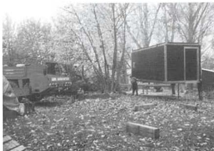
Zuerst wurden die Container komplett ausgeschlachtet. Alle Wand- und Deckenverkleidungen wurden entfernt, die alte Unterkonstruktion wurde teilweise wiederverwendet, entsprechend mit Metallplatten verstärkt und für die Montage der Wasser- und Elektroinstallation vorbereitet. Es wurde eine Stahlkonstruktion angefertigt auf der die Container jeweils einzeln stehen, so dass bei Hochwasser des Mains unser neues Sanitärzentrum verschont bleiben möge.
